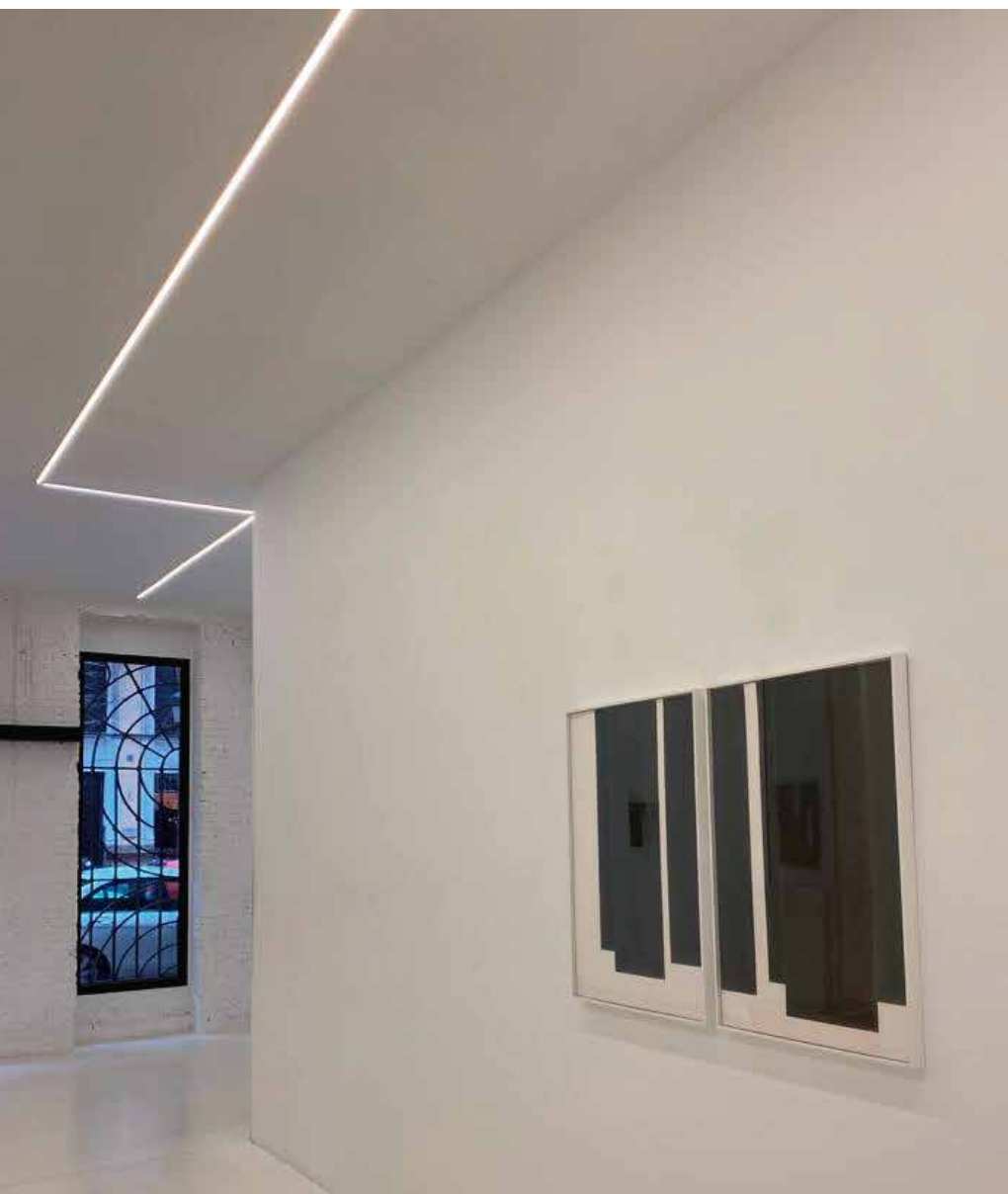
Tira LED 80 24V 28W/238 "Tera" en Galería Punto, Valencia / Electro-Villanueva
